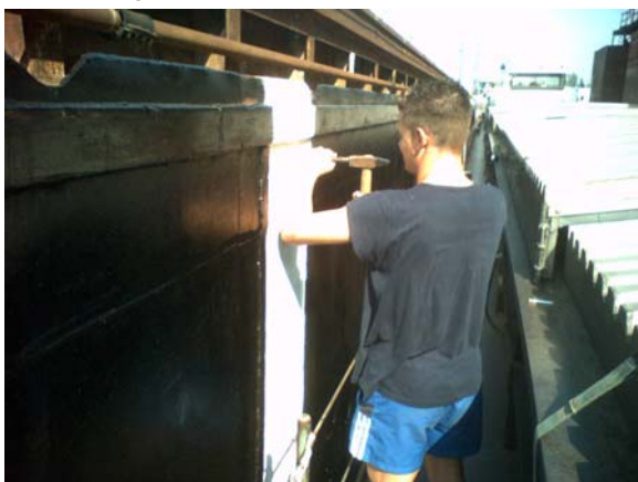
Anbringen der Einsenkungsmarke
